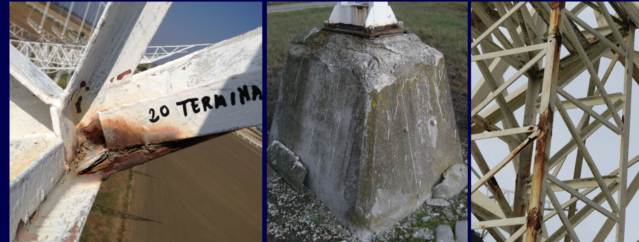
Stato del ramo Est-Ovest prima dei lavori di ripristino
