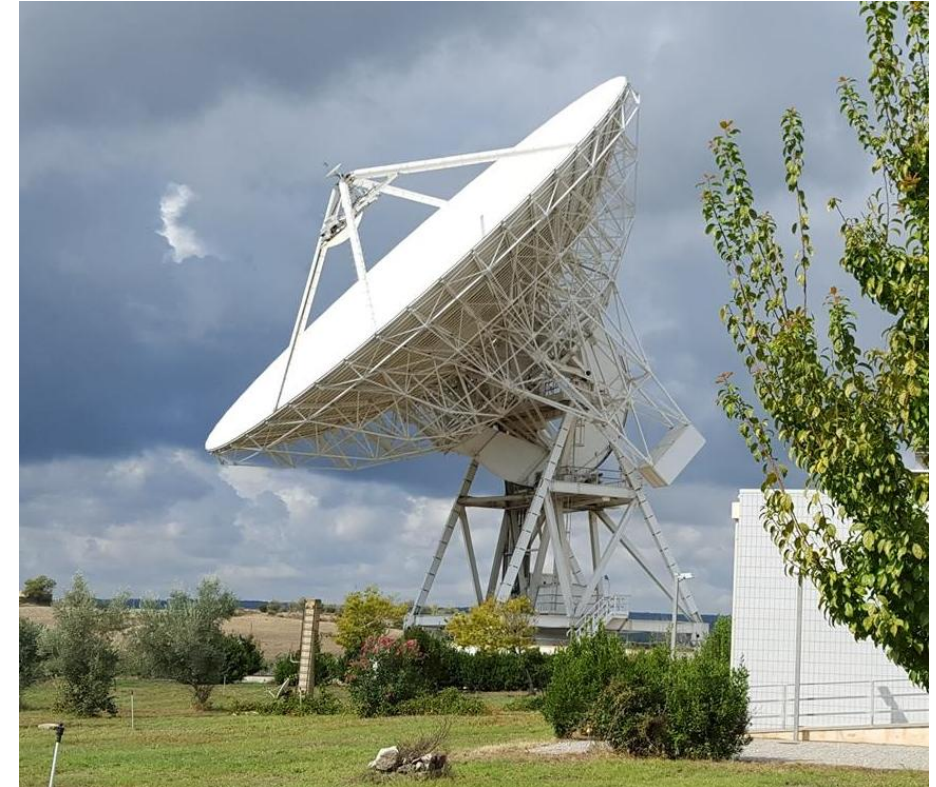
Antenna parabolica di Noto
