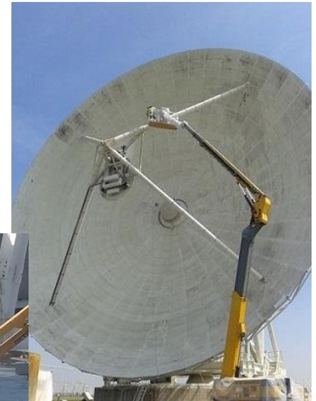
Verniciatura del quadripode
