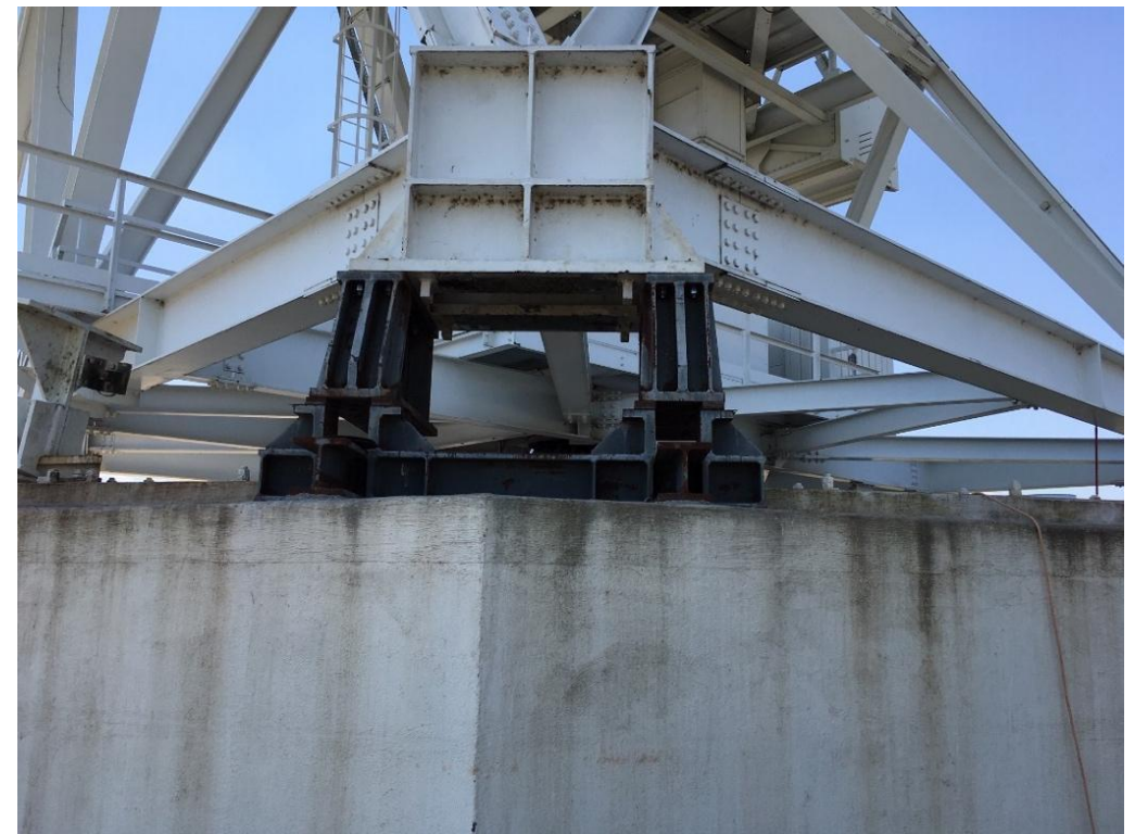
Completo sollevamento antenna – Gruppo ruota rimosso
