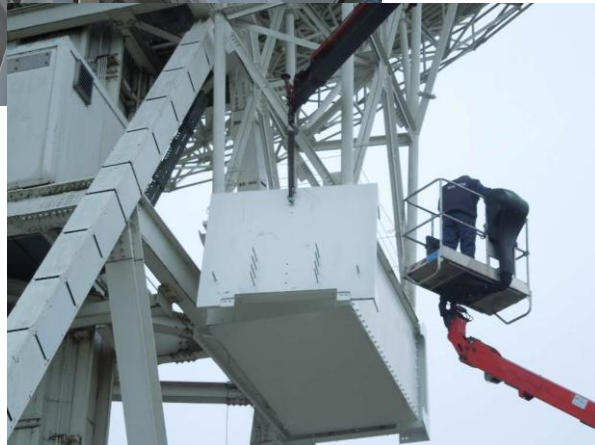
Installazione Struttura Contrappesi
