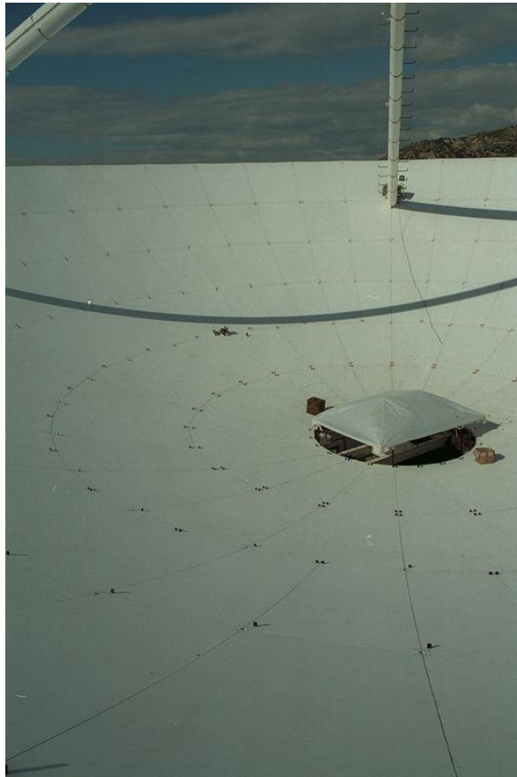
Specchio primario con pannelli installati
