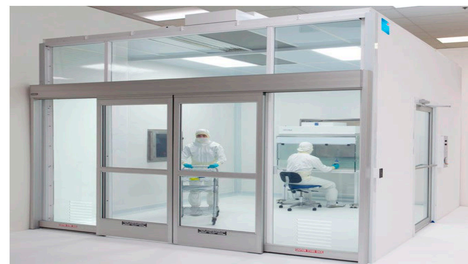
Fig.2 Esempio similare di clean room classe 100
